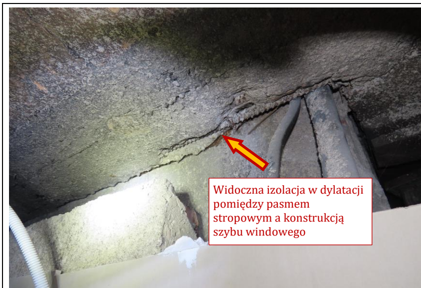
Fot. 55 Widok odkrywki na drugim piętrze – widoczna dylatacja pomiędzy konstrukcjami
