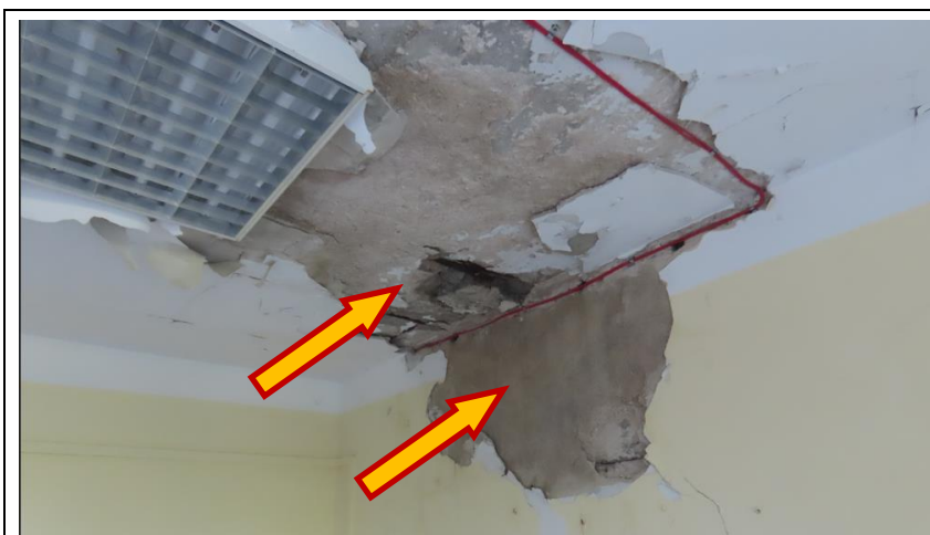
Fot. 9 Obszar 1 Odspojenie fragmentu betonu w obrębie wylewki oraz płyty grzewczej. Ślady po wilgoci na ścianach oraz stropie.
