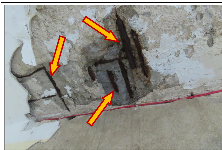
Fot. 10 Obszar 1 Odspojenie fragmentu betonu w obrębie wylewki oraz płyty grzewczej. Skorodowane zbrojenie główne oraz kanały grzewcze. Widoczne wypełnienie wnęki w płycie.
