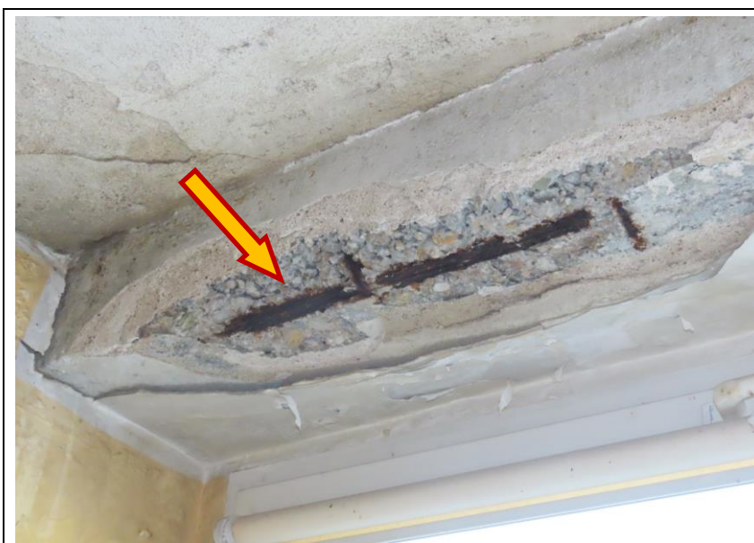
Fot. 7 Odspojenie fragmentu betonu podciągu zewnętrznego. Widoczne skorodowane zbrojenie. (pomieszczenie poza zakresem opracowania)
