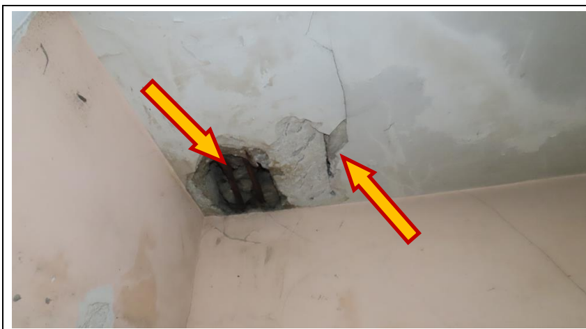
Fot. 11 Obszar 2 - Wnęka w płycie grzejnej. Widoczne rury grzejne oraz przecięty pręt zbrojeniowy. Odspojenie tynku na styku płyta – wylewka.
