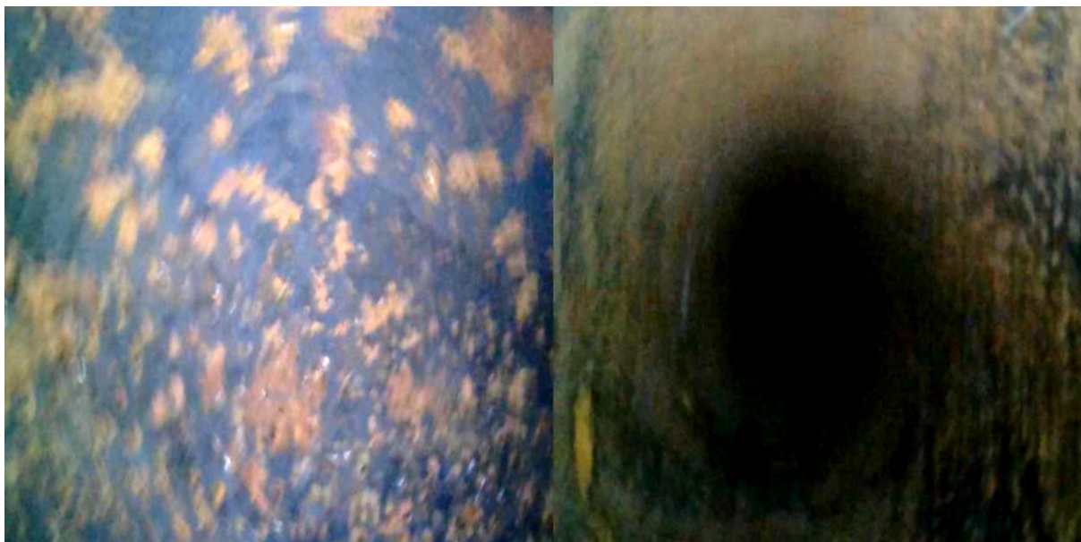
Fot. 28 Widok wewnętrzny kanału.
