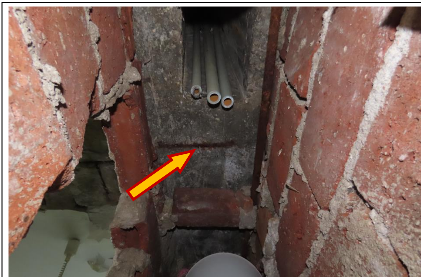
Fot. 5 Obszar 1- Brak otuliny strzemienia w podciągu. Widoczne ślady korozji.
