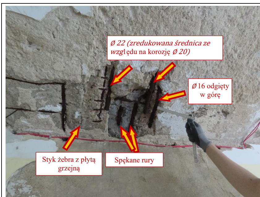
Fot. 23 odkrywki w płycie grzejnej – nr 1.4.
