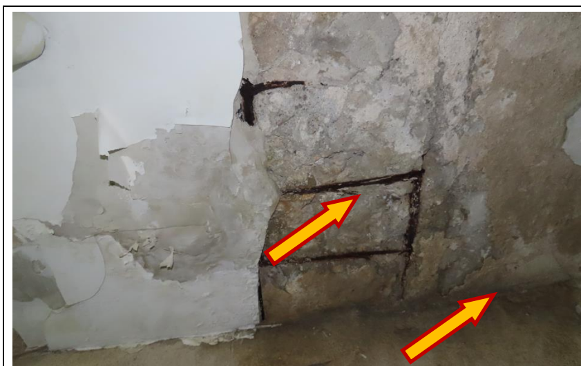
Fot. 4 Obszar 1 - Widoczne ślady po zawilgoceniu tynku na stropie i podciągu. Odspojenie fragmentów betonu. Skorodowane zbrojenie wylewki oraz brak otuliny.
