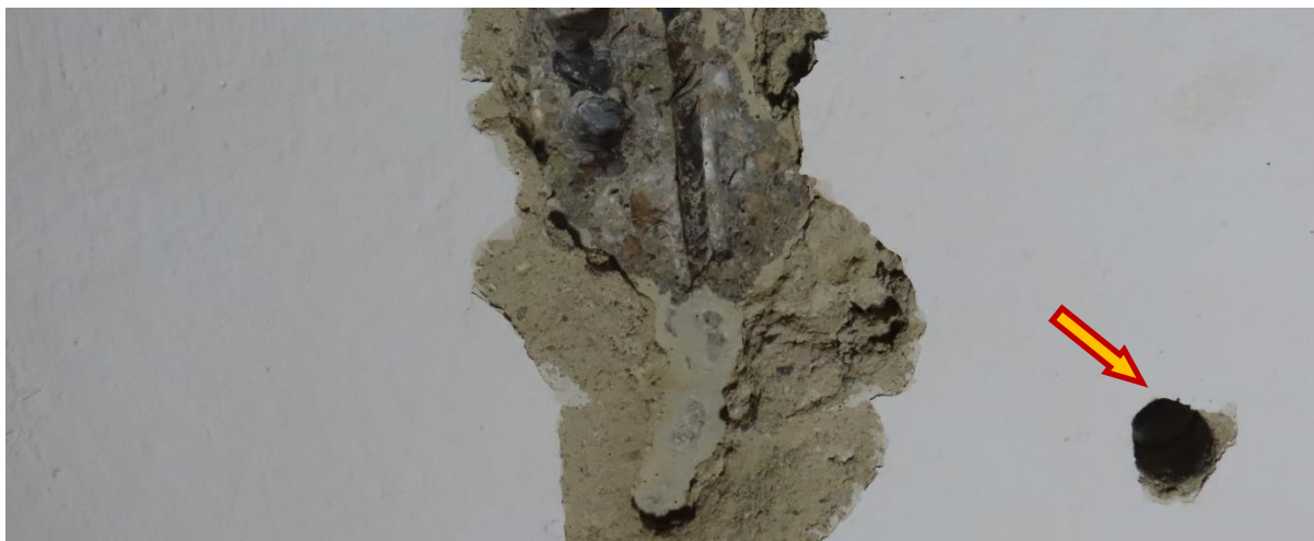
Fot. 37 Widok odwiertu na obszarze nr 3 w okolicach punktu 3.1
