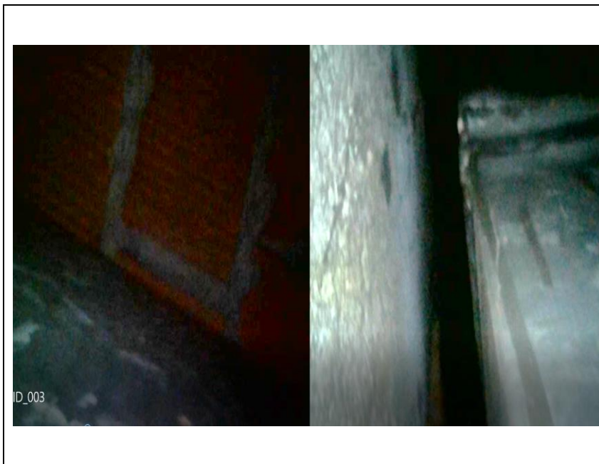
Fot. 52 Przewiert 2 – widoczna przestrzeń szachtu biegnącego wzdłuż szybu windowego. Na lewej grafice widoczne elementy ceramiczne ograniczające szacht instalacyjny. Na prawej grafice widoczny kanał wentylacyjny biegnący w przestrzeni szachtu.
