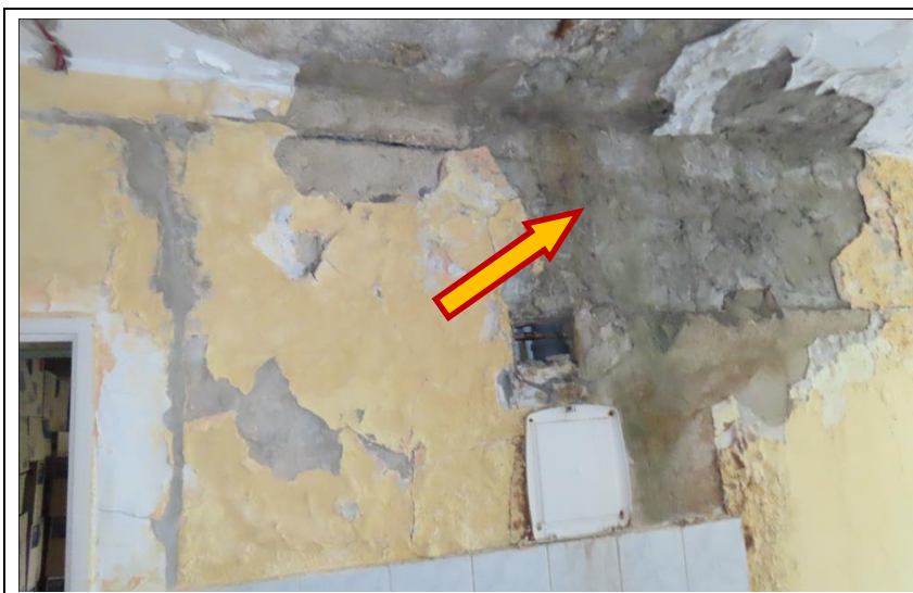
Fot. 6 Widoczne ślady po zawilgoceniu tynku na stropie, ścianie i podciągu. (pomieszczenie poza zakresem opracowania)
