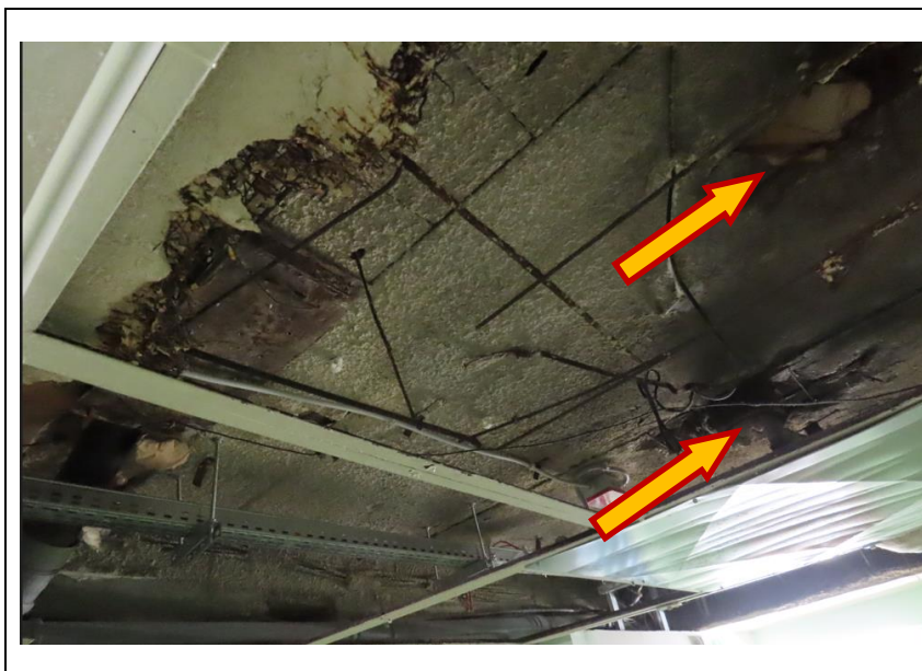
Fot. 14 Widok stropu na korytarzu w sąsiedztwie obszaru 3 z usuniętym fragmentem sufitu podwieszanego. Widoczne uszkodzenia prętów w obrębie przejść instalacyjnych. W pozostałych fragmentach stan płyt można ocenić jako zadowalający.
