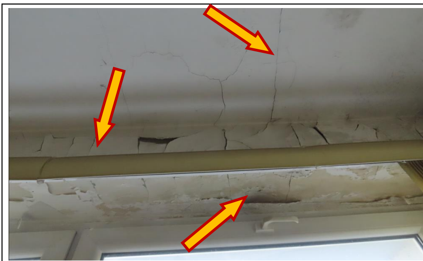
Fot. 8 Obszar 1 Widoczne uszkodzenia warstw wykończeniowych w obrębie podciągu skrajnego.
