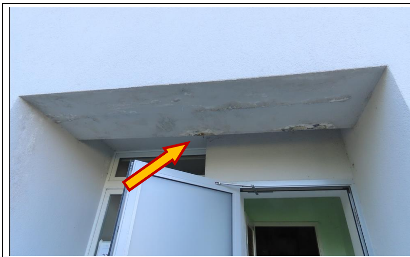
Fot. 2 Obszar 1 - Ślady po zaciekach na spodniej części podciągu.
