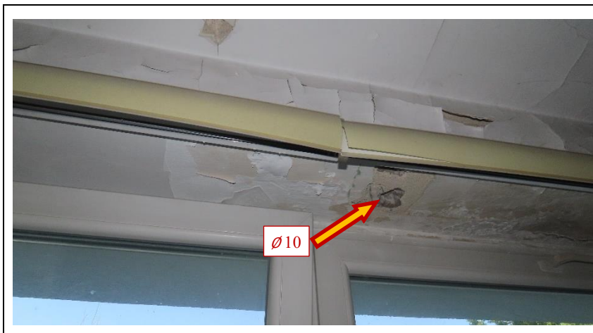
Fot. 25 Odkrywka w podciągu Poz.3.13 – nr 1.6.
