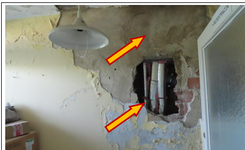
Fot. 3 Obszar 1 - Widoczne ślady po zawilgoceniu tynku na ścianach i podciągu, uszkodzona ściana wypełniająca z cegły dziurawki.
