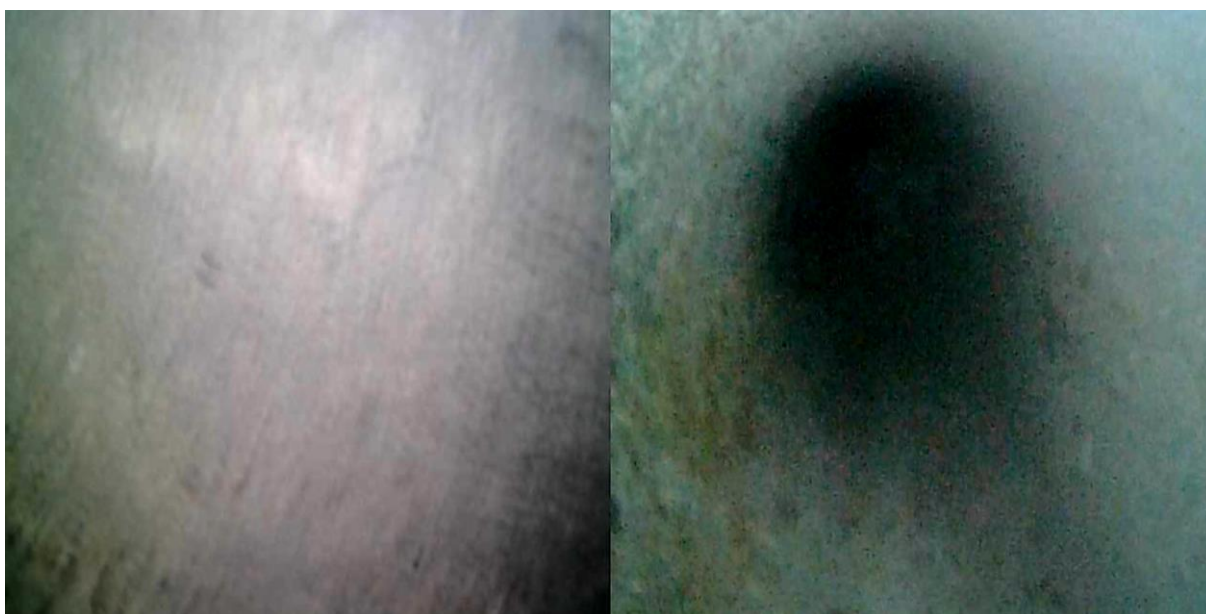
Fot. 38 Widok nawierconego kanału płyty S4
